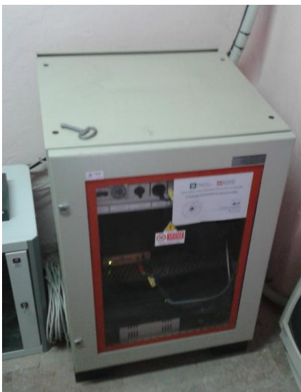
Armadio contenente il ricevitore ed il gruppo UPS
